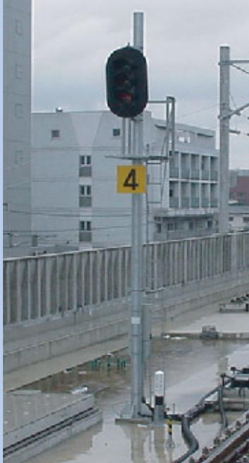
信号機柱（鋼管柱）
